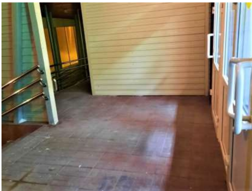
Фото 7. Входная площадка (перед дверью)
