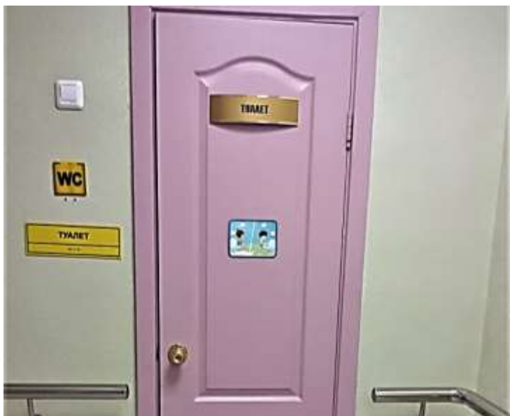
Фото 26. Дверь санитарного помещения
