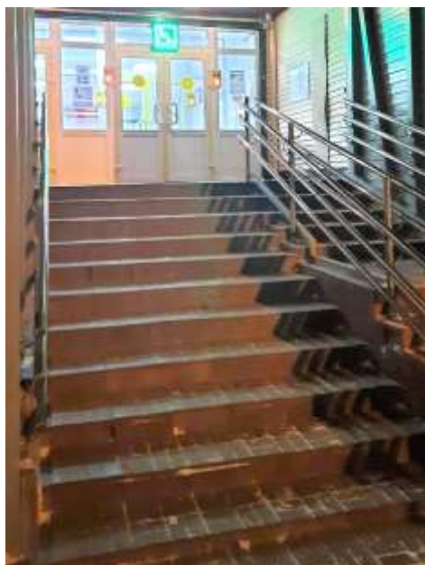
Фото 3. Лестница (наружная) общая
