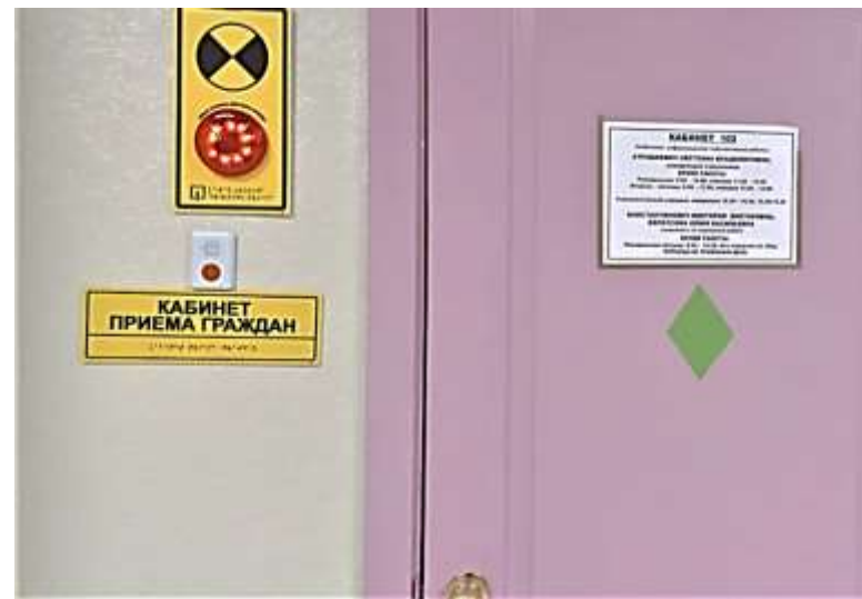
Фото 58. Тактильно-звуковые информаторы НОТТ установлены около дверей кабинетов, где предоставляются услуги детям-инвалидам, инвалидам с нарушениями зрения
