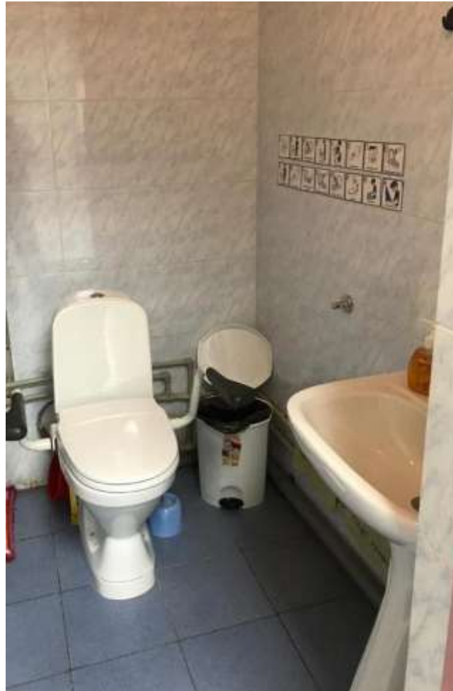
Фото 41. Туалетная комната на 1 этаже, унитаз, оборудованный поручнями
