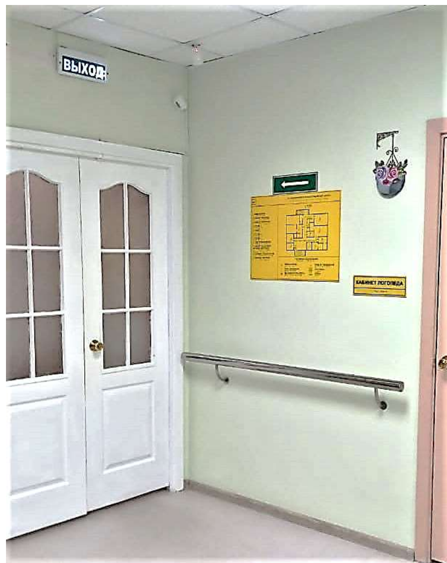
Фото 25. Дверь со стороны холла
