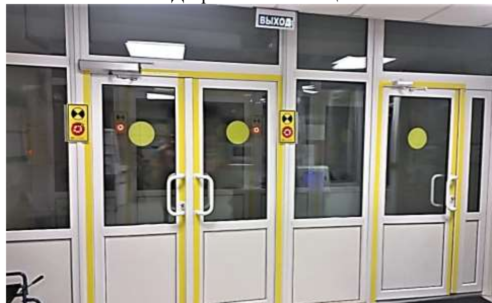
Фото 29. Основной эвакуационный выход
