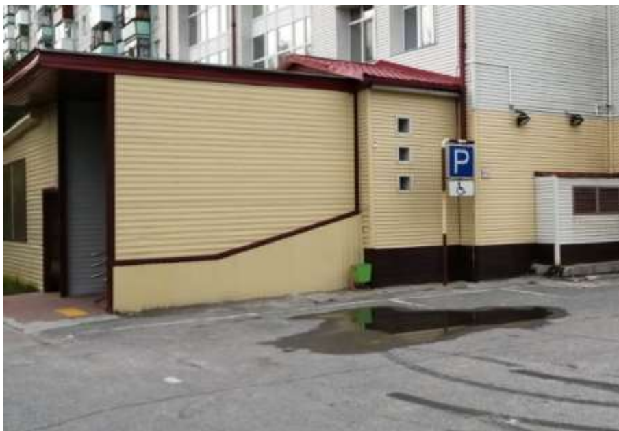
Фото 1. Парковка около здания БУ «Радужнинский реабилитационный центр»
