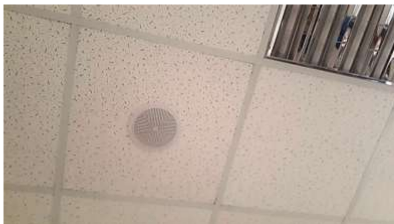
Фото 59. Звуковой оповещатель о пожаре
