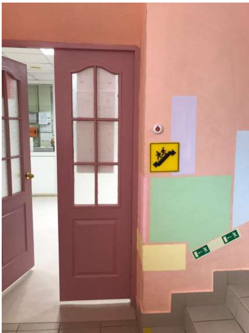
Фото 18. Лестница внутри здания, вход на лестницу первого этажа
