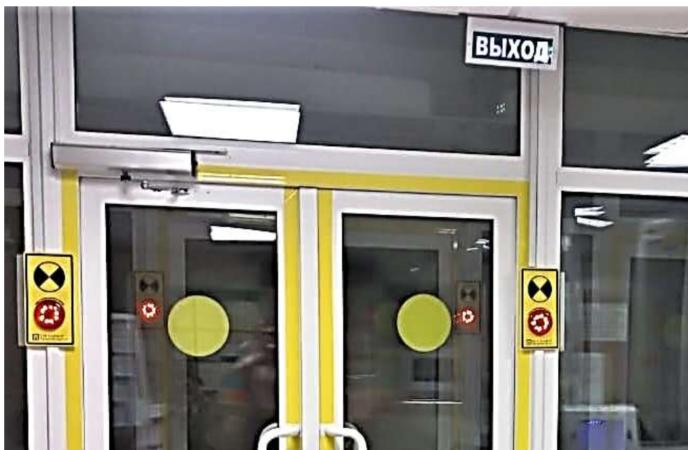
Фото 55. Световой указатель «Выход» (основной эвакуационный выход)
