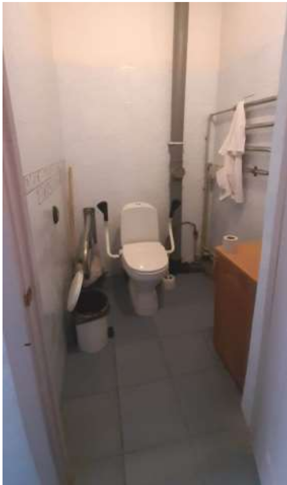
Фото 46. Туалетная комната на 3 этаже, унитаз, оборудованный поручнями
